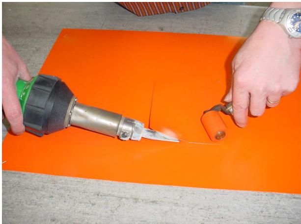
Anschliessend wird der ganze Flickstoff ringsum vollflächig verschweisst. Das Schweißen geschieht kontinuierlich und zügig. Bei zu langsamen Arbeiten, besteht die Gefahr von Verfärbungen, bis hin zu Brandlöchern. Bei zu schnellem Arbeiten verschmelzen die Materialien ungenügend und das Loch wird nicht dicht sein.
